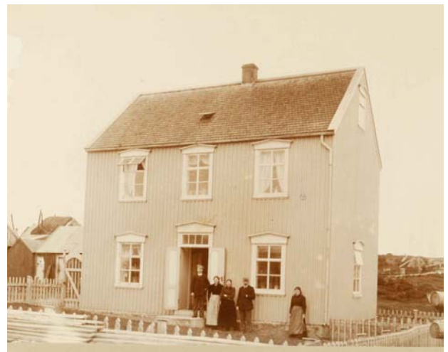
Upprunalegt útlit Vogs, listaþil á veggjum, bjór yfir gluggum og dyrum og spónn á þaki. Þjms. L.pr. – 3183.
