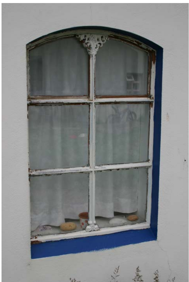
Allir steypujárnsgluggar í Bogabúð hafa verið endurgerðir í upprunalegri mynd.
