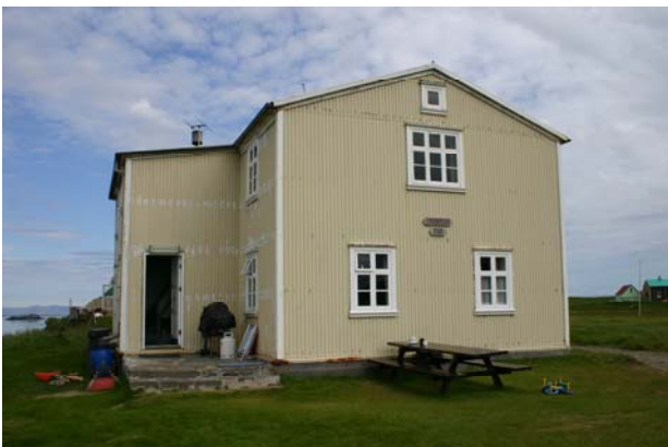
Vesturstafn og norðurhlið Bentshúss.
