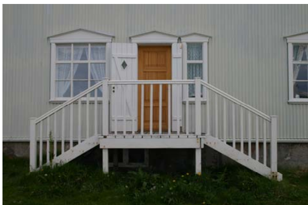
Aðalinngangur hússins og trétröppur framan hans.
